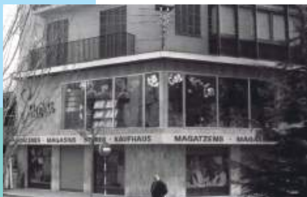
L'actual edifici acabat de construir, el 1968. (Juli Barber)
