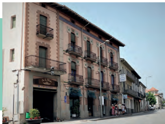
Foto actual de la façana de la fonda.
